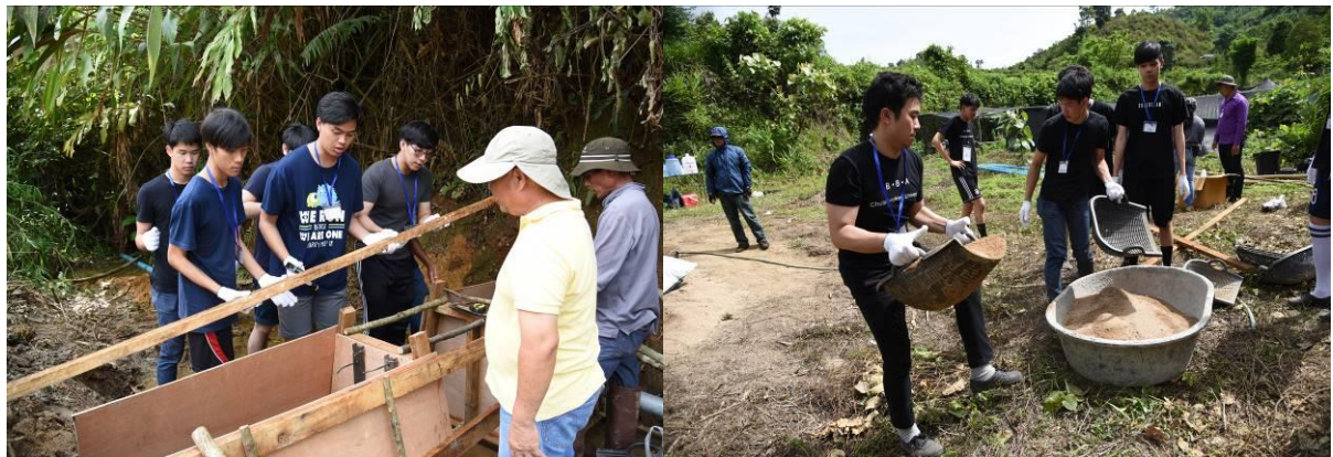
ทีมผู้ช่วยแบ่งงานมาขึ้นโครงสร้างผนังตัวฝาย และขนทราย หินกรวดใส่กระบะปูน
