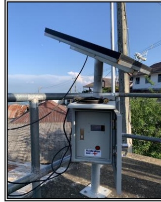
ระบบเตือนภัยทำงานด้วยพลังงานโซลาร์เซลล์
